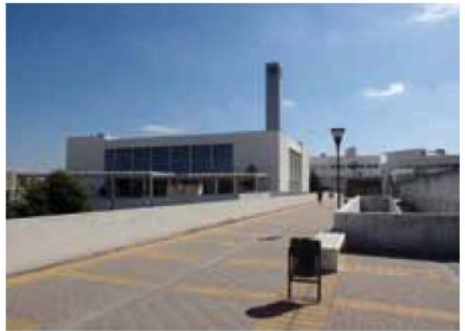
Nuevo Edificio Multiusos en el Campus de Jerez
