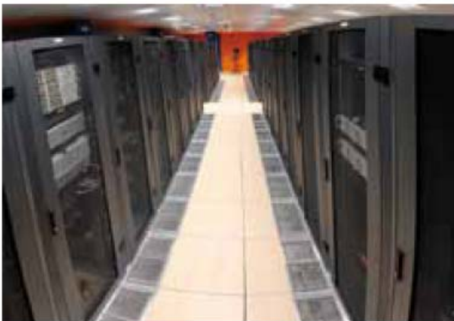
Nuevo Centro de Proceso de Datos
